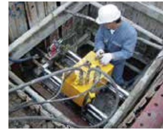
⑤パイロット削孔状況(立坑内設置型)
