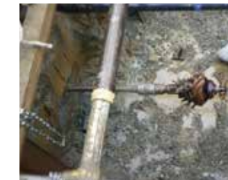
①バックリマ取付状況
