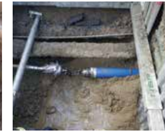
④埋設管引込完了
