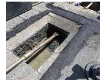
④貫入開始状況
