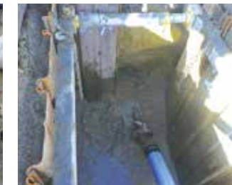
②埋設管引込開始状況
