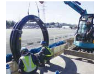
③ポリエチレン管引込状況
