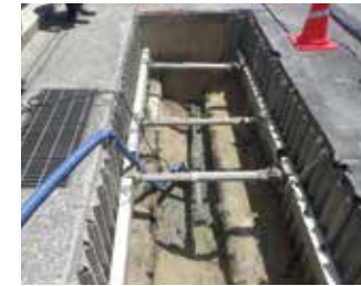
⑦パイロット削孔完了
