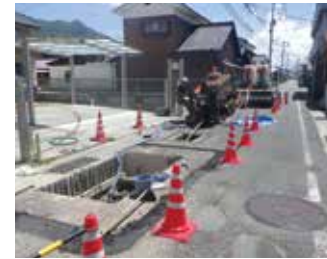
⑤パイロット削孔状況(地上設置型)
