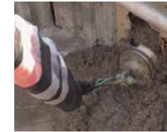
③電力用管引込状況(2条1束)
