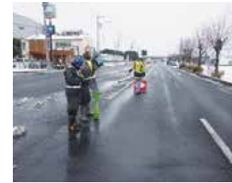
⑥ロケータリング状況
