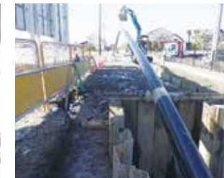
③ポリエチレン管引込状況
