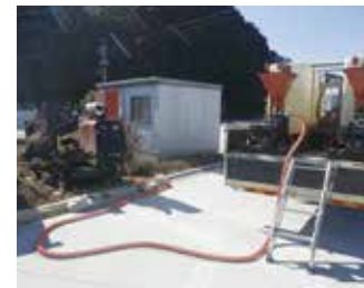
①ドリルユニット設置状況
