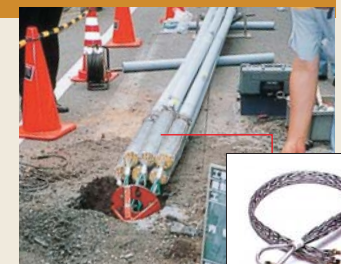
③パイプ引き込み
