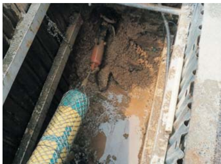
ガス管推進工事 宮城県 仙台市
