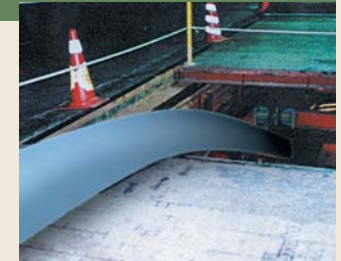
③パイプ引き込み
