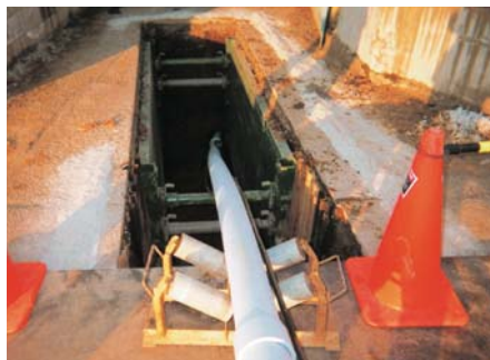
真空下水管推進工事 茨城県 境町
