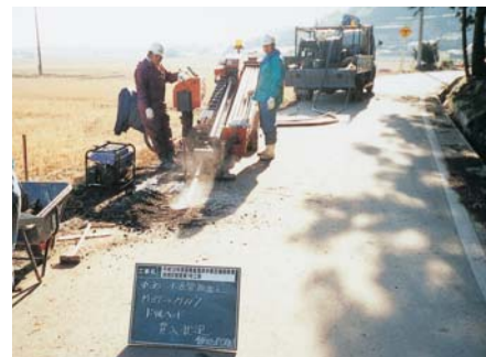
配水管推進工事 千葉県 多古町
