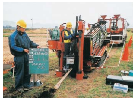
真空下水管推進工事 福島県 猪苗代町
