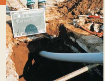
③パイプ引き込み
