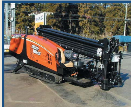
1.ドリルユニット据え付け
