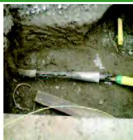
●カッター、PE管設置
