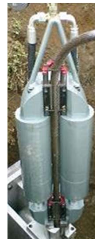
ワイヤ引き込み状況
