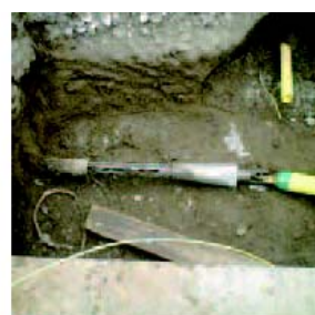
●カッター、PE管設置
