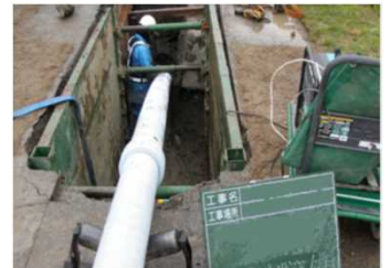
PE管引込状況
