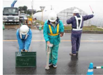
ローケーティング状況
